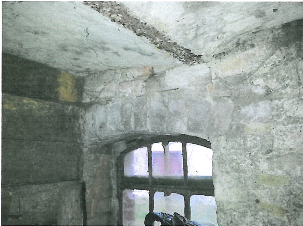
Widoczny wpływ wilgoci na konstrukcje budynku.
