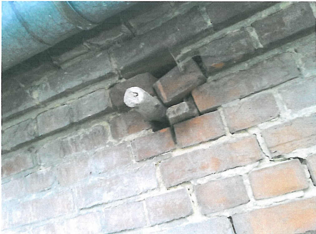
Widoczne ubytki w spoinach.
