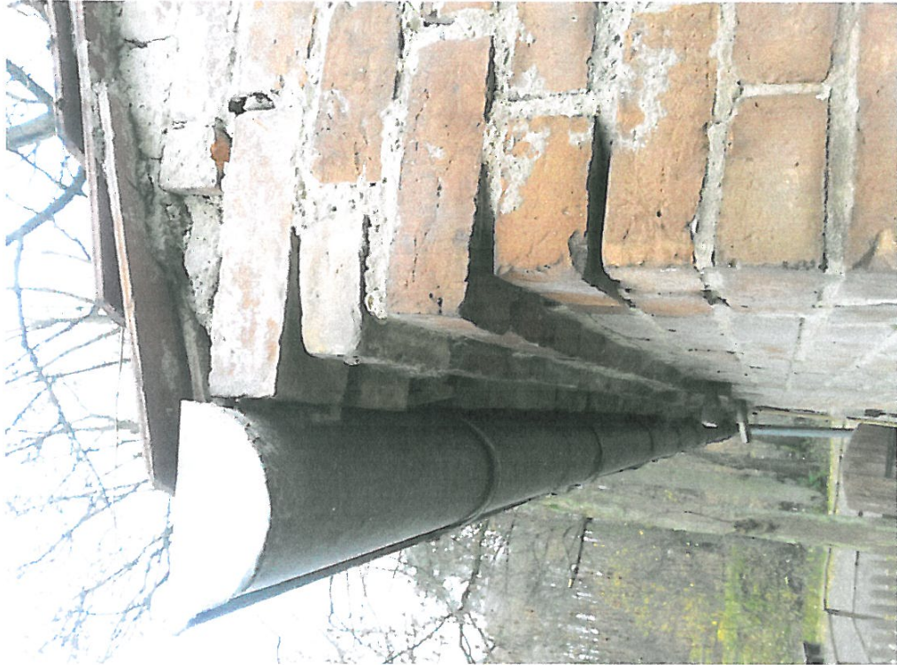
Widoczne ubytki w spoinach.
